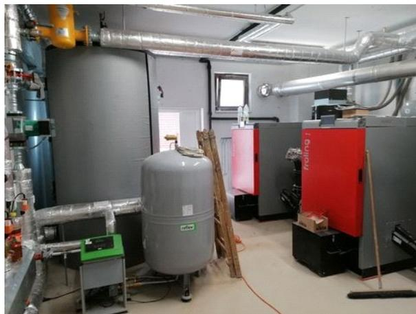
Entfernung der Gasheizung im Kindergarten und Anschluss an eine Pelletsheizung
