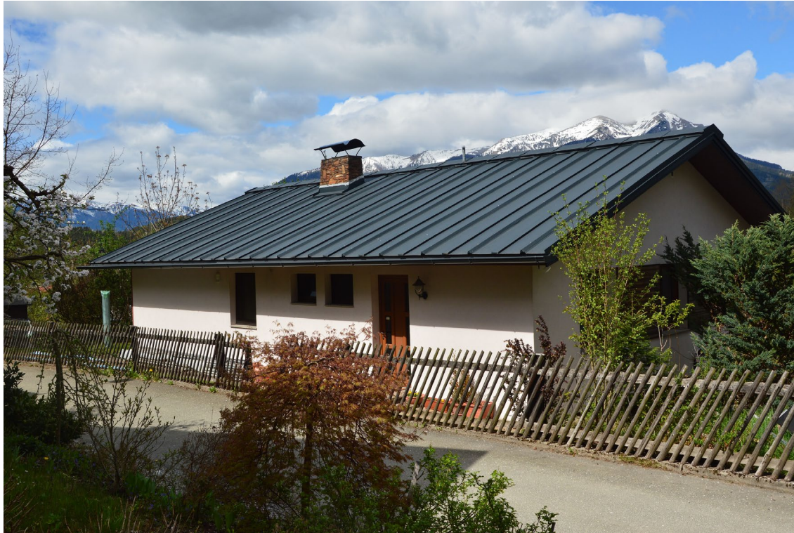
Energydach zur Gewinnung von Wärme
