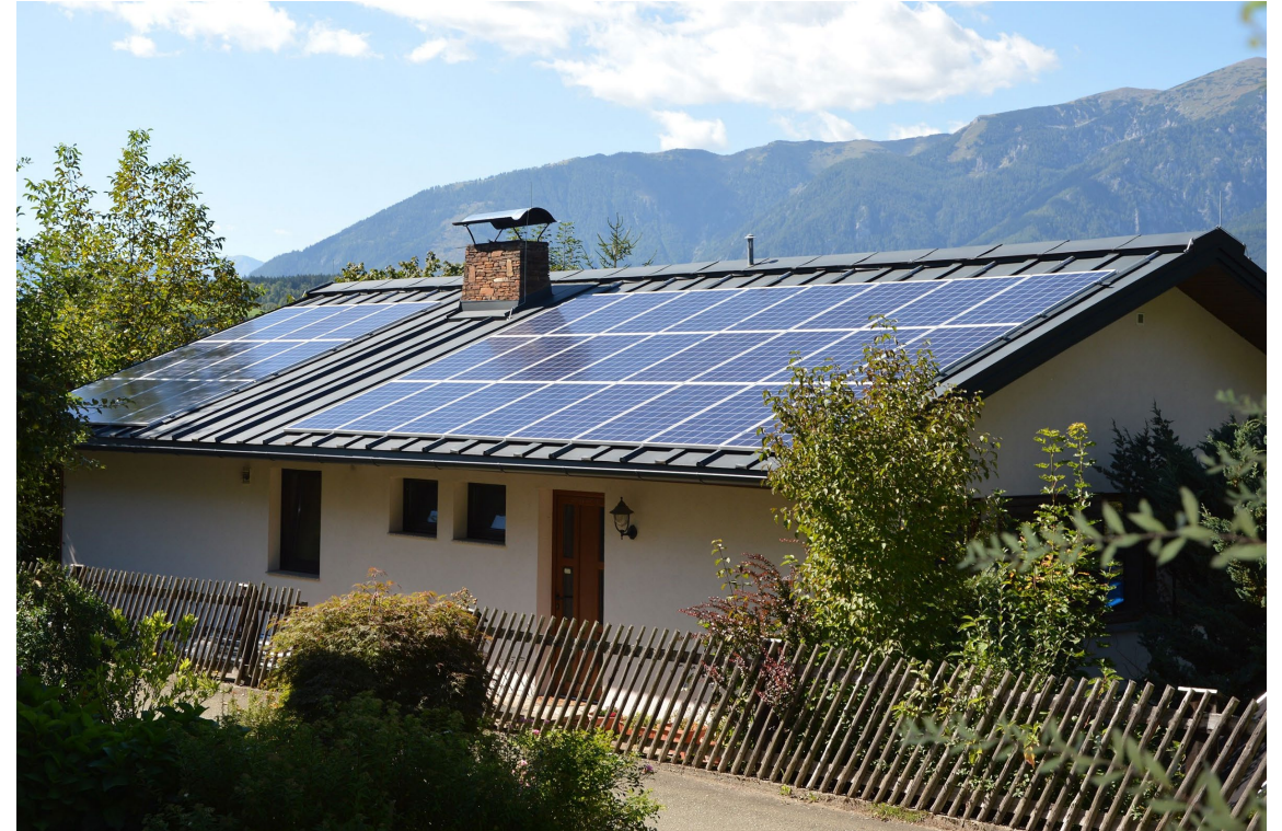
Energydach mit Photovoltaikmodulen zur Gewinnung von Wärme & Strom
