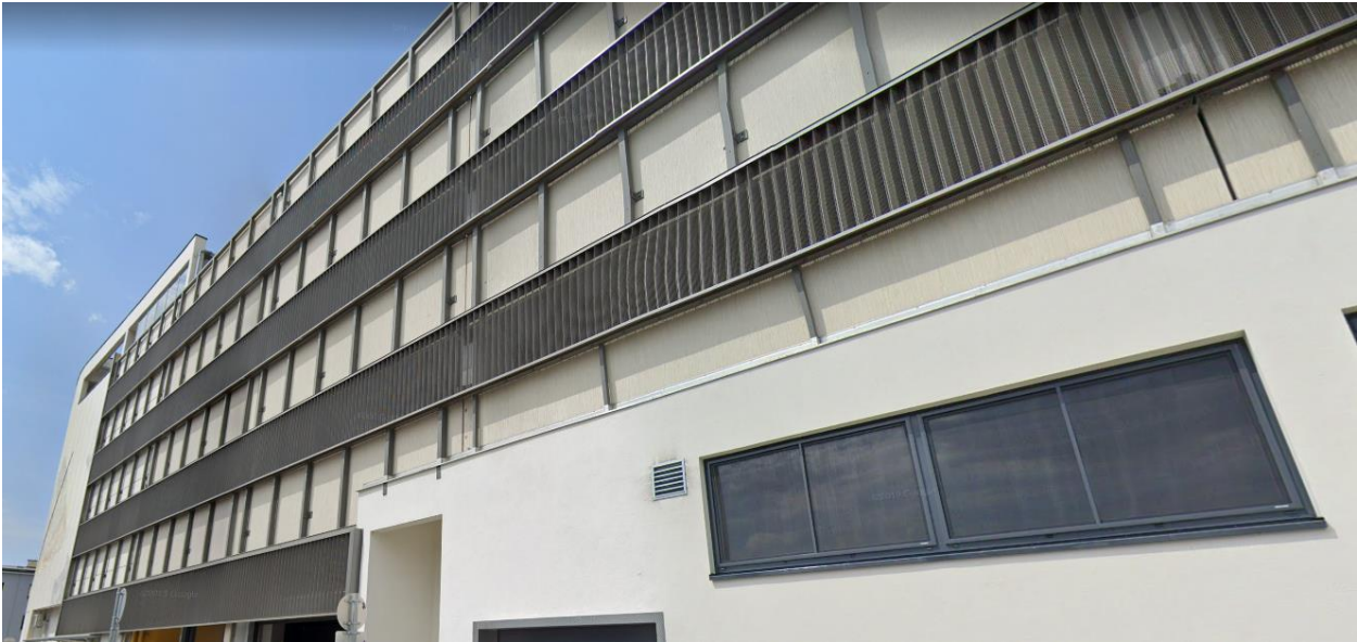
Abbildung 8: Fassade vor dem Umbau
