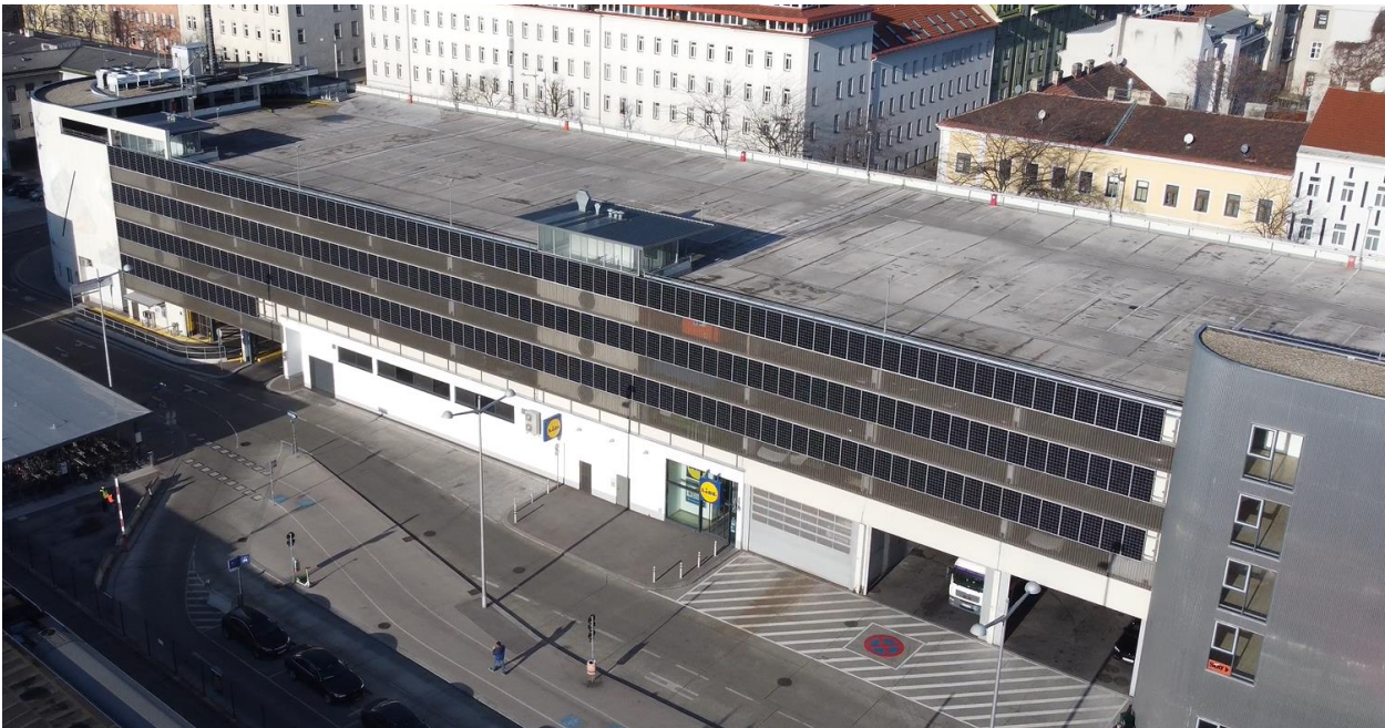
Abbildung 1: Gesamtansicht der Anlage
