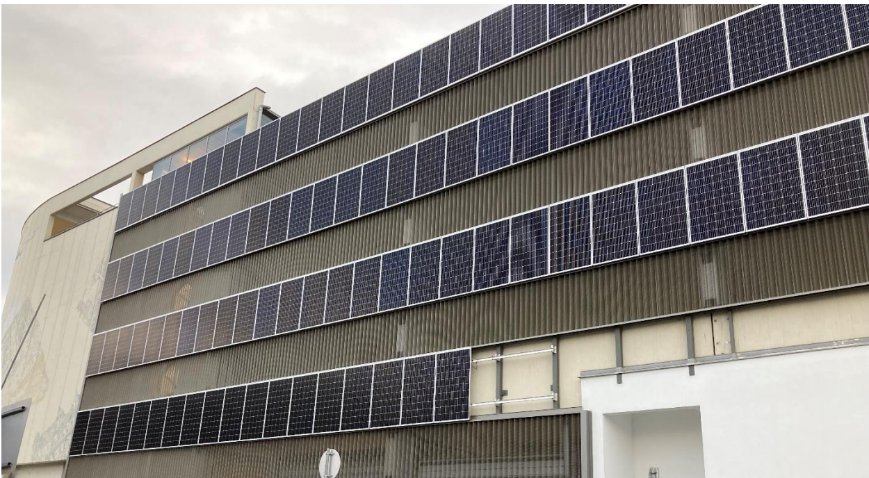
Abbildung 9: Fassade nach der Integration der PV Module in die Fassade
